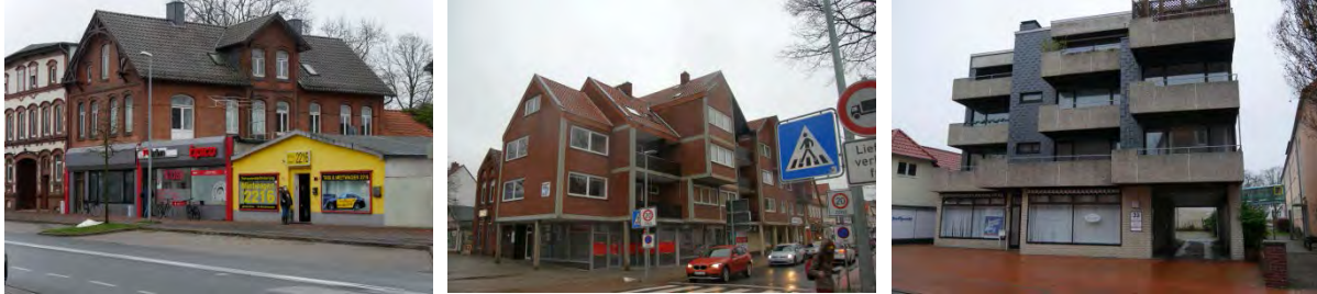
Abb. 10 Gebäude mit ortsbildstörender Wirkung (Auswahl)
