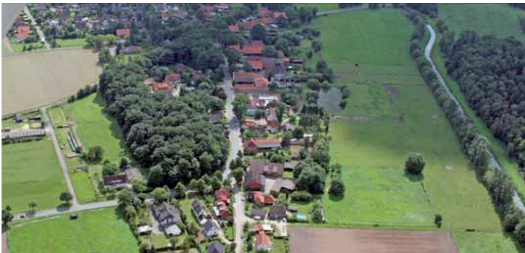
Abb. 4.1/2 Dachtmissen von Norden
