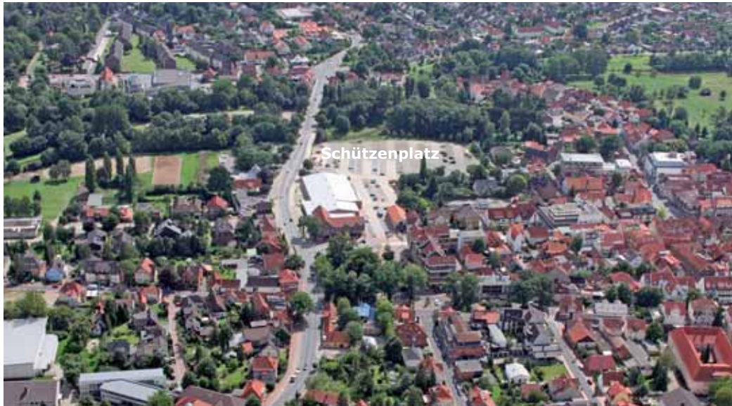
Abb. 7.4/1 Schützenplatz von Norden
