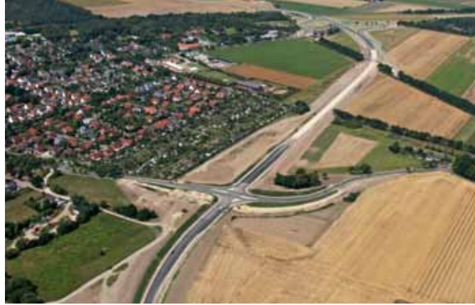
Abb. 4.3/20 Nordumgehung, 2009 noch im Bau
