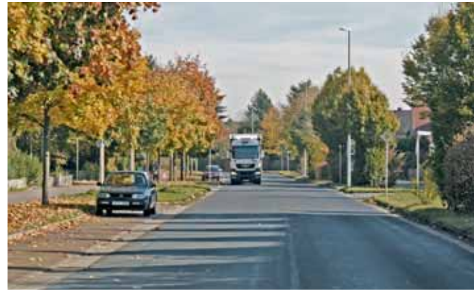
Abb. 4.3/30 Ostlandring, südwestlicher Abschnitt
