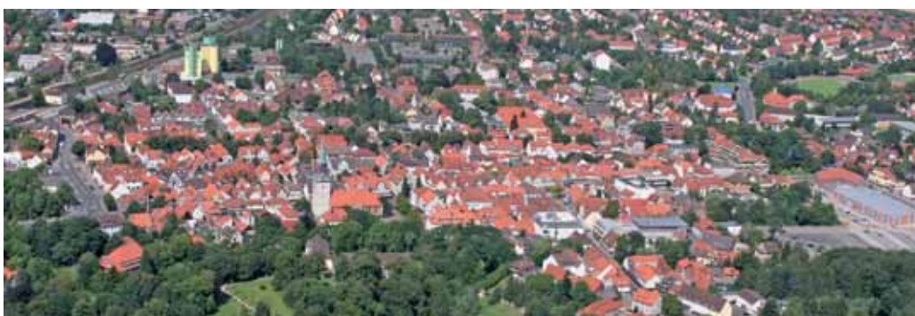
Abb. 4.2/14 Burgdorf von Süden
