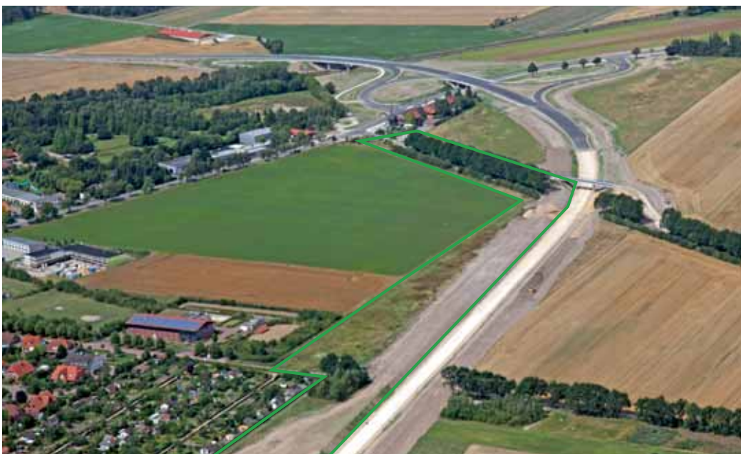
Abb. 4.3/25 Nordoststadt: Brücke über die B 188 neu und Potential für Grünzug
