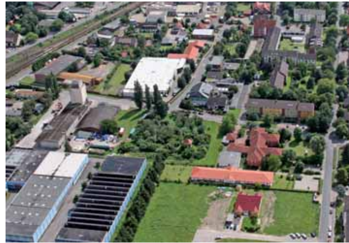
Abb. 4.2/19 Nebeneinander von Gewerbe und Wohnen, Am Güterbahnhof
