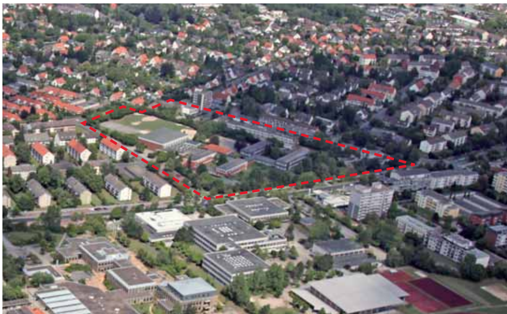
Abb. 4.2/11 Nahversorgungszentrum Rubensplatz, Untersuchungsbereich Stadtumbaugebiet
