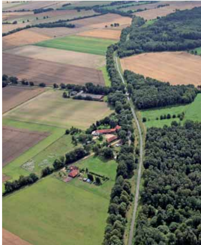
Abb. 3.1/1 Gehöfte in Flaatmoor, Ansicht von Norden
