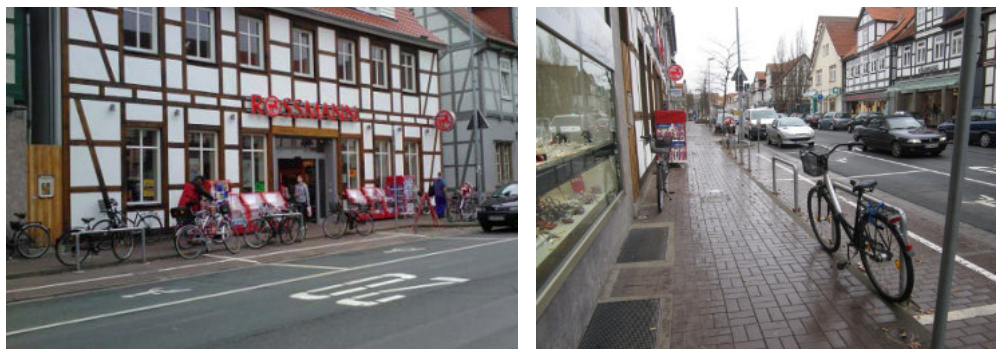
Abb. 63: Rahmenhalter in Längsaufstellung im Zuge der Marktstraße
