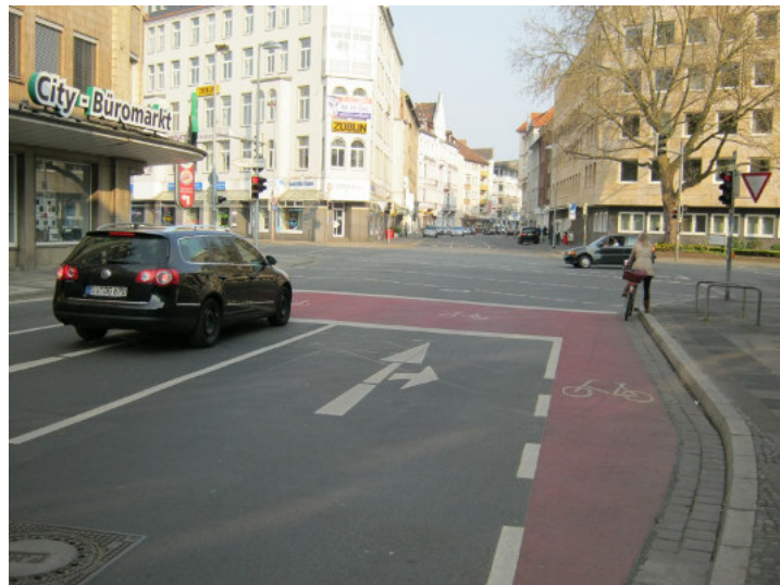
Abb. 37: Aufgeweiteter Radaufstellstreifen (ARAS) mit Möglichkeit zum direkten Linksabbiegen (Hannover).
