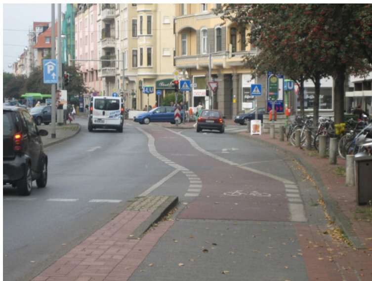
Abb. 35: Übergang Radweg in Radfahrstreifen an signalisiertem Knotenpunkt (Hannover)
