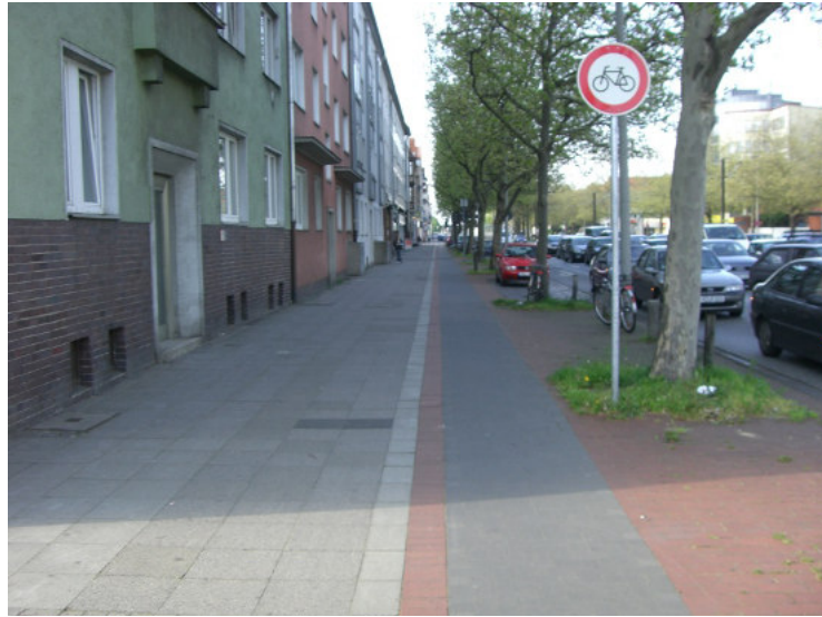
Abb. 43: Verdeutlichung des Endes eines Zweirichtungsradweges durch Z 254 StVO (Hannover)
