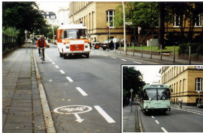
Abb. 30: Schutzstreifen als Schonraum für Radfahrer und als „Reservefläche“ für große Fahrzeuge (Bonn).
