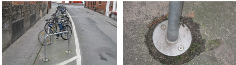
Abb. 62: Beispiel für verschraubte Rahmenhalter (Lüneburg)
