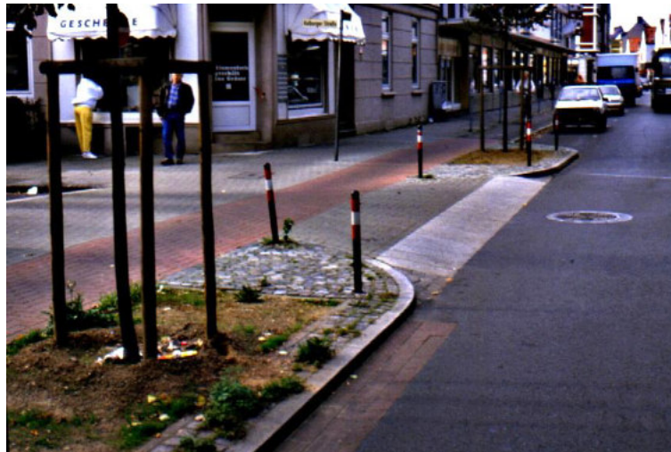
Abb. 34: Teilaufpflasterung im Einmündungsbereich einer Nebenstraße (Bremen).
