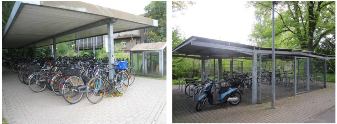
Abb. 88: Fahrradabstellanlage Ehlershausen/Edenthal mit Vorderradklemmen und Fahrradabstellanlage Ehlershausen/Bussardweg mit neuem überdachten Rahmenhalter und Fahrradkäfig
