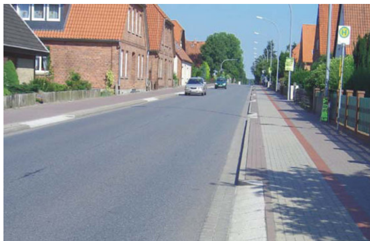
Abb. 41: Grundstückszufahrten mit Rampenstein (Soltau)
