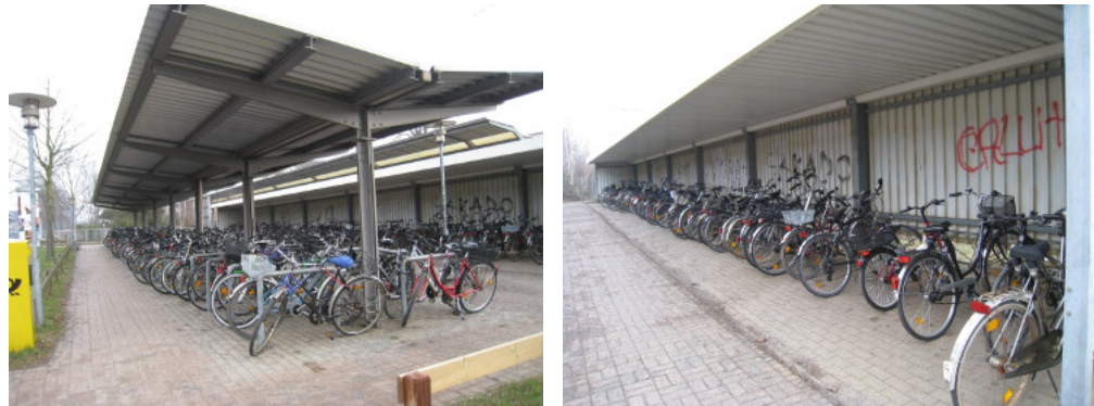
Abb. 85: Überdachte Abstellanlage westlich des Bahnhofes, die nur z.T. den gerade für Langzeitparker besonders wichtigen Diebstahlschutz bietet
