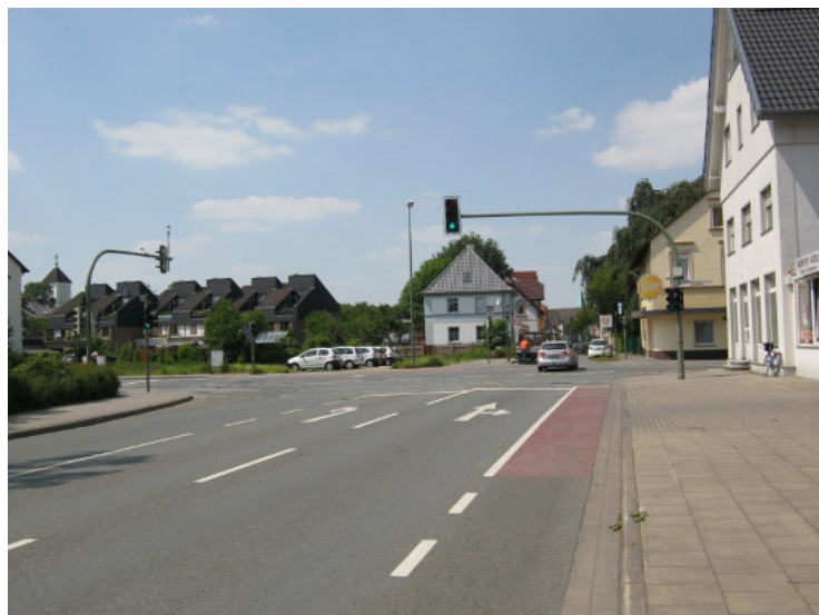
Abb. 36: Vorbeifahrstreifen in einer signalisierten Knotenpunktzufahrt mit zusätzlicher Rotmarkierung (Bielefeld)
