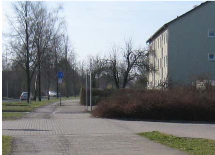
Abb. 26: Benutzungspflichtiger baulicher Radweg (Burgdorf, Ostlandring)
