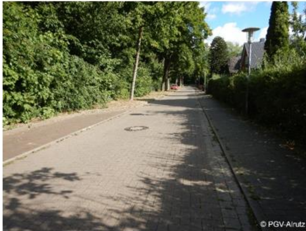
Foto aus Blickrichtung Süden
