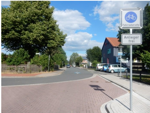
Aufpflasterung der untergeordneten Straßen
