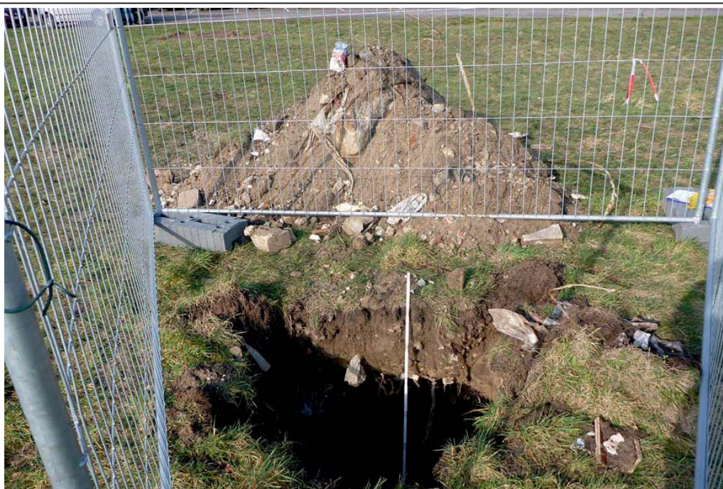
Abb.3: Schurf-Nr. 11: Baggerschurf bis ca. 1,7 m u. Gok. - Boden-Bauschutt-Hausmüll-Gemisch (ca. 30 - 50 Vol.-% bodenfremde Bestandteile z.B. Beton, Kalksandstein, Ziegel, Altmetall (Dosen, Farbeimer), Kunststoffe, Glas, Teerpappe. (12.02.2016).
