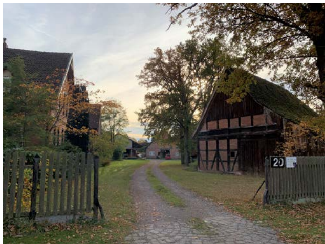
Historische Hofanlage in Ramlingen
