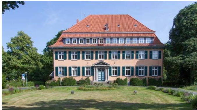
Ehemalige Landratsvilla in Burgdorf (heutiges Rathaus II) Quelle: STADT BURGDRF
