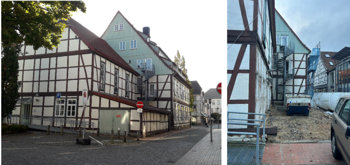
Abbildung: Arbeiten an der Nordwestseite - Abbruch des Schuppens. Fotos: Stadt Burgdorf.
