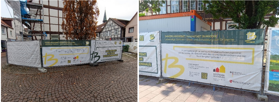
Abbildung: Hinweis auf die anteilige Finanzierung durch die Städtebauförderung am Bauzaun. Fotos: Stadt Burgdorf.
