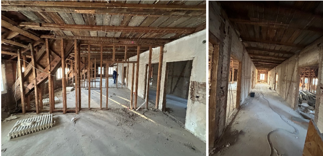
Abbildung: Arbeiten im Gebäudeinneren. Fotos: Stadt Burgdorf.
