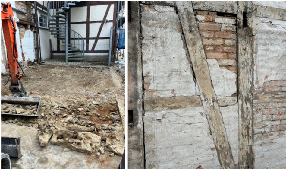
Abbildung: Abbruch des alten Schuppens und Untersuchung des Tragwerks. Fotos: Stadt Burgdorf.
